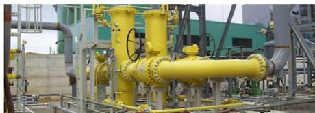
Cicloni in acciaio al carbonio, cilindrici e tronco conici di grosso diametro.
